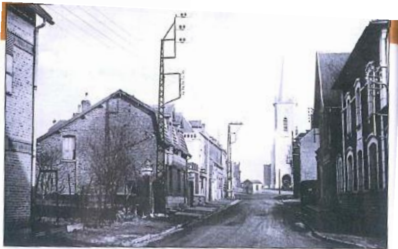
Ci-dessus : vue de la rue St Léger en direction de l'église (reconstruite après 1918). L'AMD a tiré en direction de la place sur des soldats allemands mais sans doute pas sur des blindés. T. Delambre a retrouvé deux impacts de balles de l'AMD toujours visibles dans la paroi de l'église. (DR.)
