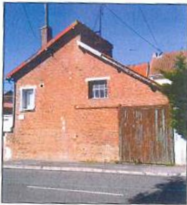
Lors de notre passage à Croisilles, nous n'avions pas réussi à localiser l'endroit où l'AMD a été détruite. Le site a finalement été identifié et photographié par Thierry Delambre.
